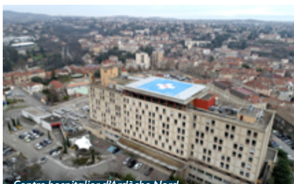
Centre hospitalier d'Ardèche Nord
