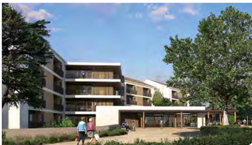
Le futur Bâtiment L USLD-EHPAD.
