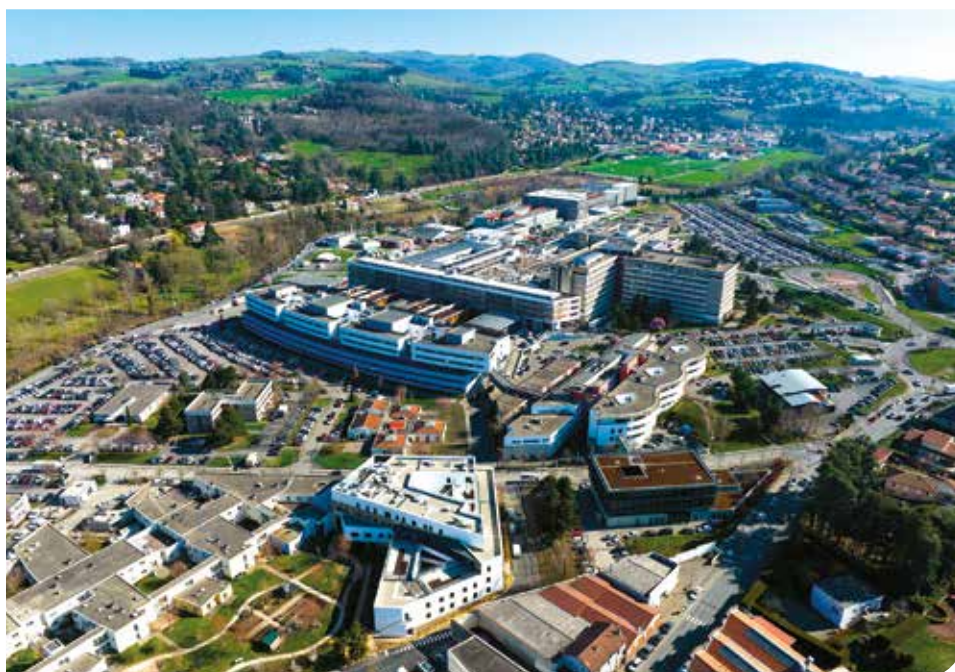
40 ans plus tard, le site Nord est devenu le centre névralgique des activités du CHU de Saint-Étienne avec au premier plan le tout dernier bâtiment de psychiatrie. © Photo Julien Rambaud.
