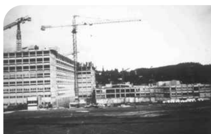
En 1982, l'Hôpital Nord destiné aux activités de pointe, sortait de terre...
