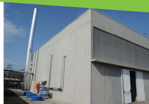
Centrale de cogénération
